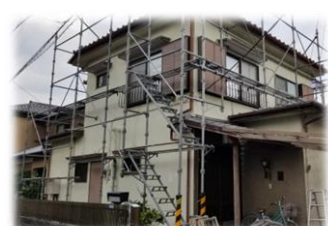
外装(外壁塗装)
